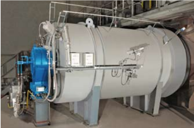
6 Heißgaserzeuger für Öl; 8,12 MW; Austrittstemperatur 800 °C 6 Hot gas generator for oil; 8.12 MW; outlet temperature 800 °C
